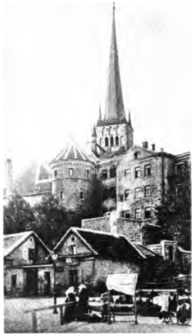
Abb. 114. Baugruppe in der Nähe der Strandpforte. (Nach Aufnahme von van der Ley.)
